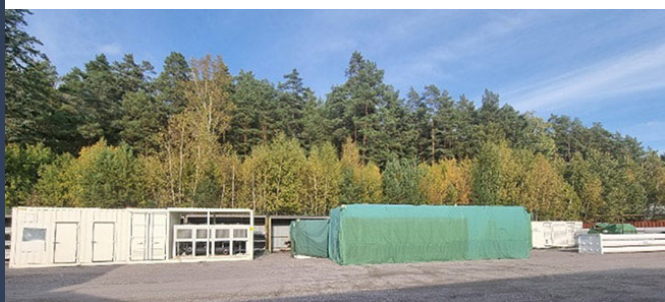
Elektrolysören i Finspång
