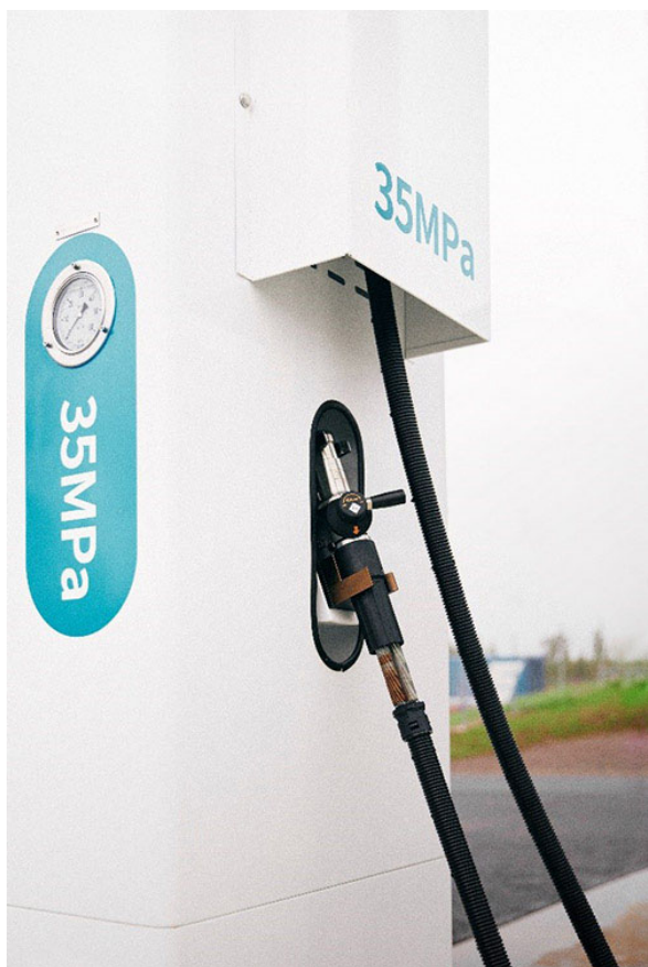
Vätgastankstation för personbilar (70 MPa) och tungafordon (35 MPa).
